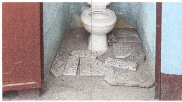
Foto 2: Sustitución de piso de torta de concreto (por piso ceramico)
