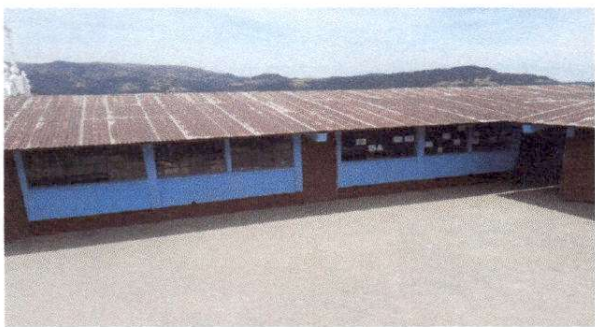
Foto 1: Sustitución de lámina, por lámina troquelada aluzinc + Sustitución de Capote de lámina para lámina troquelada + Sustitución de elementos de fijación
