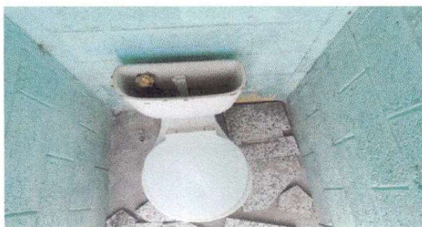
Foto 3: Sustitución de inodoro + Sustitución de Tubería de PVC linea principal aguas negras
